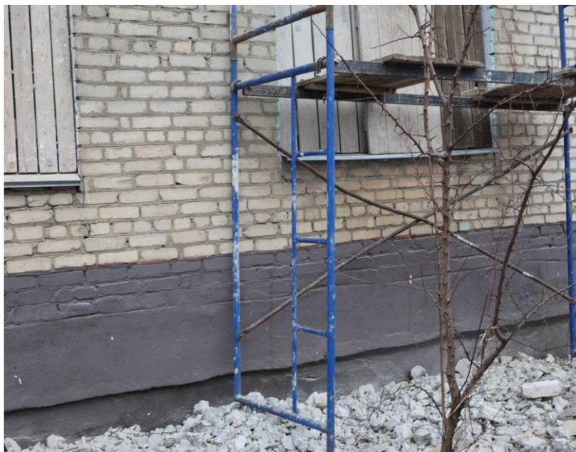
*Поверхность грунта, на которую установлены средства подмащивания, не спланирована (не выровнена и не утрамбована)*
