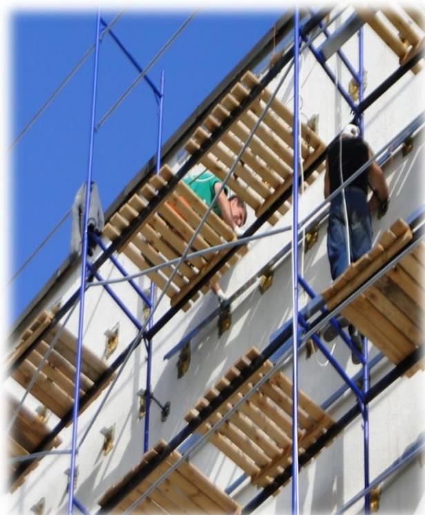
*На лесах отсутствуют необходимые защитные ограждения, нарушены требования по охране труда при устройстве настилов. Выполнение работ без применения средств индивидуальной защиты*
