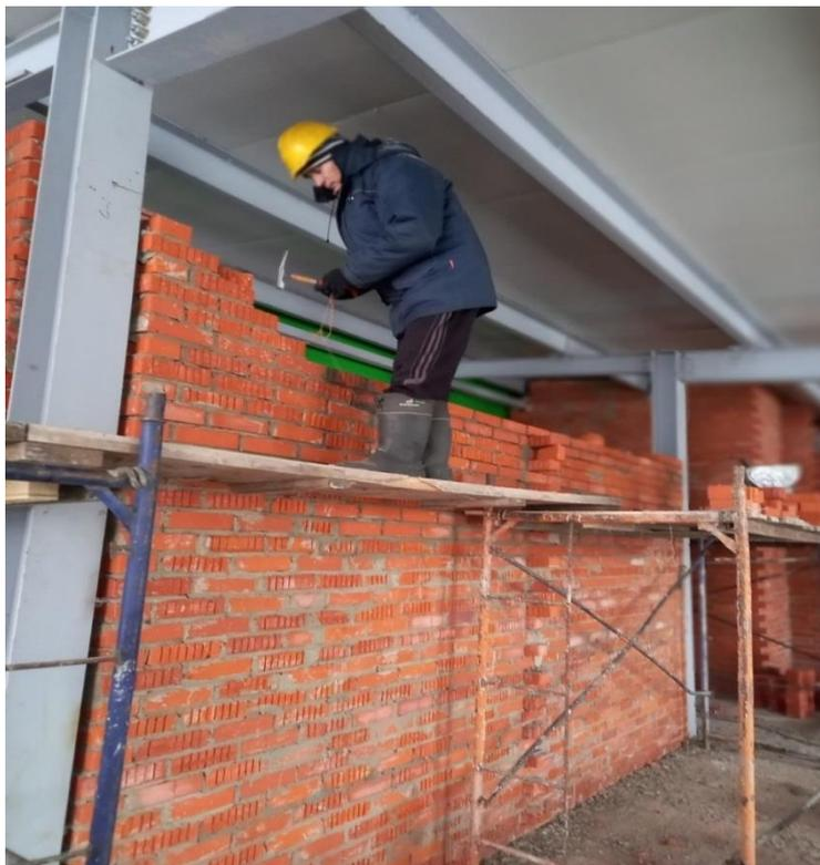
*На средства подмащивания отсутствуют ограждения, ширина настила на подмостях при выполнении каменных работ менее 2 м*
