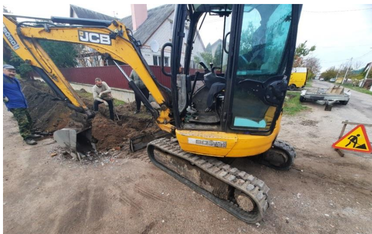
Экскаватор оставлен с включенным двигателем, опасная зона не ограждена
