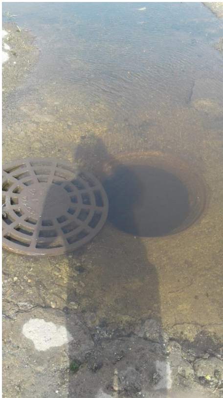
Не закрыты люки подземных приемников сточных вод
