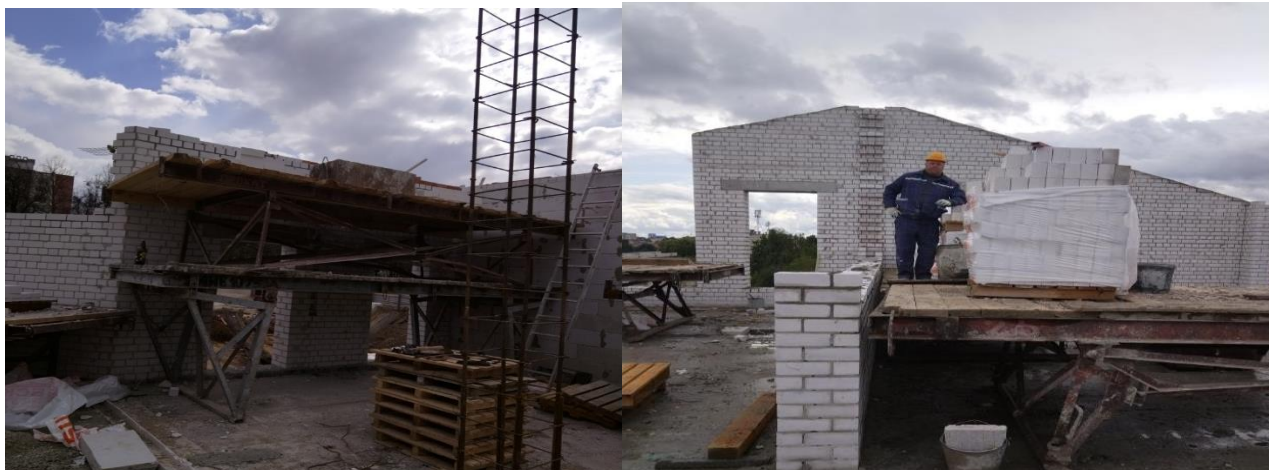
Подмости не оборудованы лестницами, обеспечивающими подъем и спуск с них работающих
