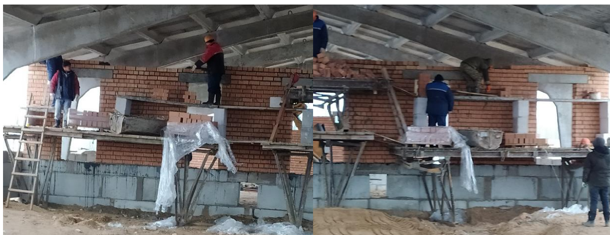
Для выполнения каменных работ используются случайные предметы в качестве средств подмащивания
