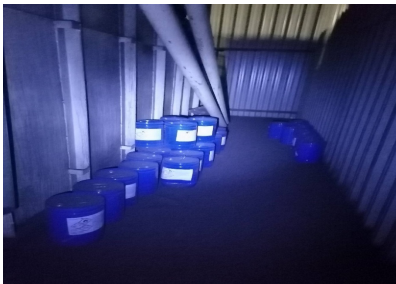
Хранение опасных химических веществ в подсобном помещении, не оборудованном механической приточно-вытяжной вентиляцией
